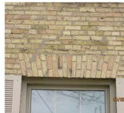
7. Brick voussoirs above windows
