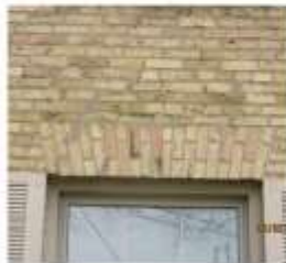
7. Brick voussoirs above windows
