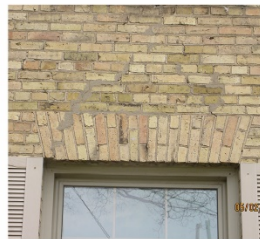
7. Brick voussoirs above windows
